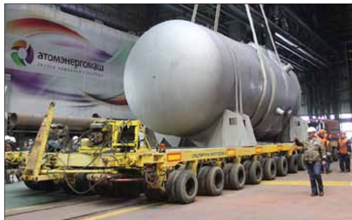
W powstającej tuż przy granicy litewskiej elektrowni doszło do upuszczenia reaktora Fot. archiwum
