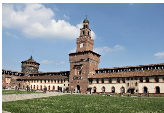
Zamek rodu Sforzów - Castello Sforzesco - Mediolan
